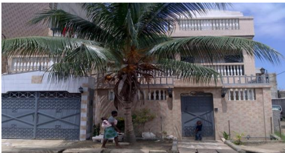
Photo 5 : Une villa duplex avec la façade extérieure carrelée à Zoé Bruno ( Cliché : ACHO Ferrand, 2017 )
